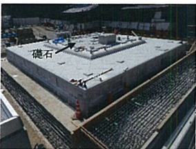
写真-5.3 基礎工事(基壇)
