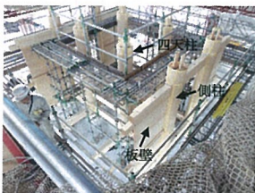
写真-5.4 初重の柱と板壁
