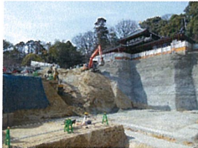
写真-5.1 掘削工事
