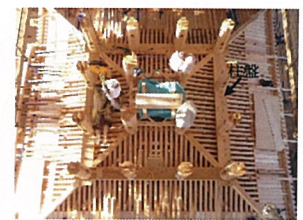
写真-5.14 側柱の柱盤
